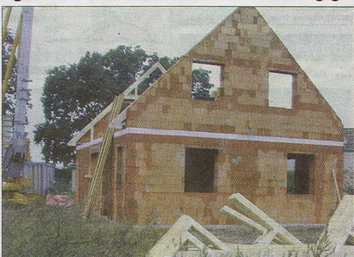
Unser Foto zeigt ein Aktionshaus vom Typ „Exzellent“, das in Massivbauweise im Wohngebiet Am Mühlgraben entsteht. Die Bauherren feiern noch im September das Richtfest.
