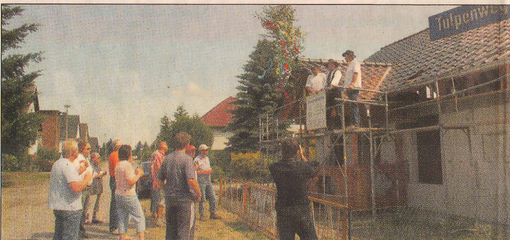
Vor kurzem: Das Richtfest für das „Musterhaus Zwei“ wurde in Genthin gefeiert.
