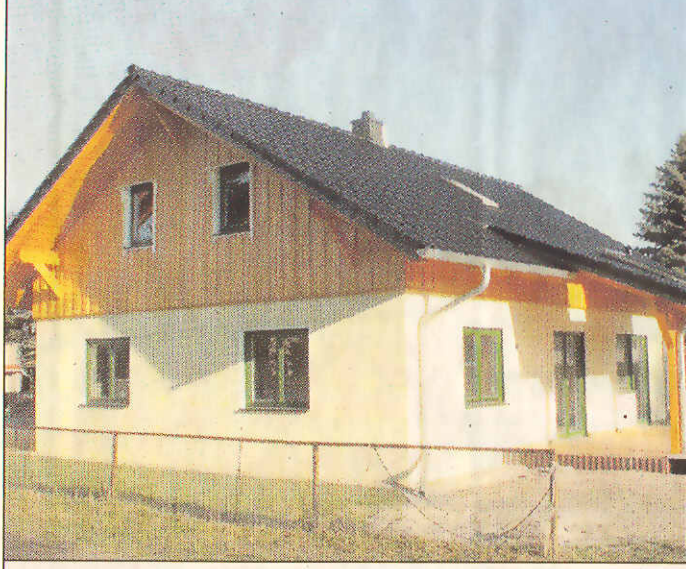
Besonders: Ein Highlight des Hauses sind die großen Dachüberstände. Fotos(3): J. Koch
